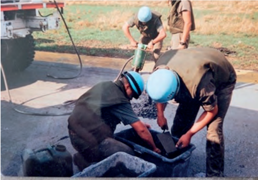
Rebouchage des trous pour rendre la piste opérationnelle avec du goudron ou du ciment prompt.
