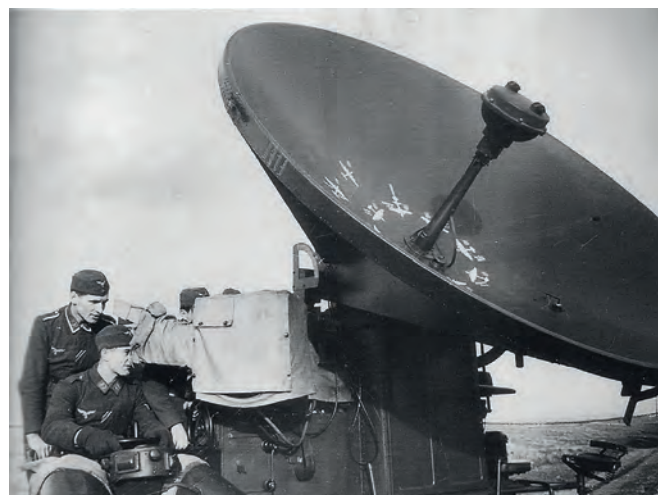
Antenne du radar Würzburg FuSE 62 D.
